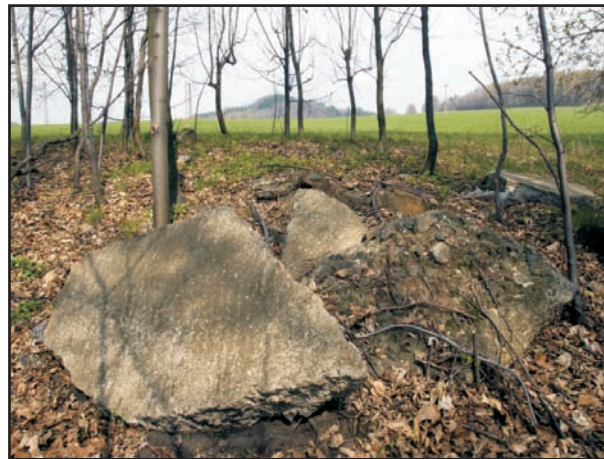
JZ okraj skládky s betonovým blokem
