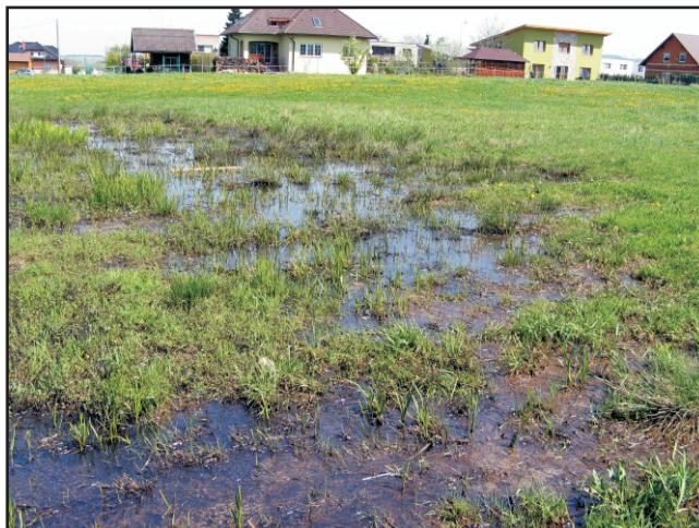
Povrchová akumulace vody pod skládkou
