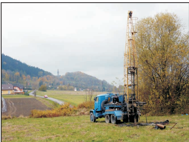
Pohled na lokalitu od S, vrtání nevystrojené sondy S3-11
