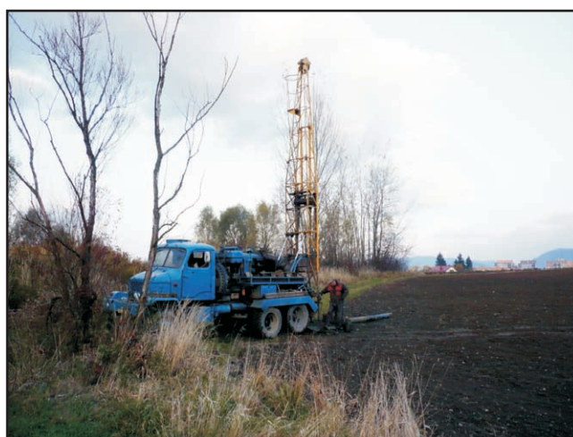
Vrtání nevystrojené sondy S3-8 v jižní části lokality
